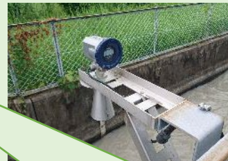
アンテナ 通信機器 制御基板 モーター類 バッテリーなどが内蔵 水位・水温センサー 既存の給水バルブ
