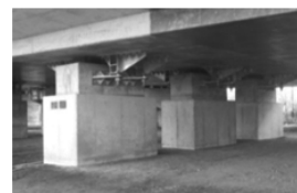
橋梁の耐震化（橋脚補強等）
