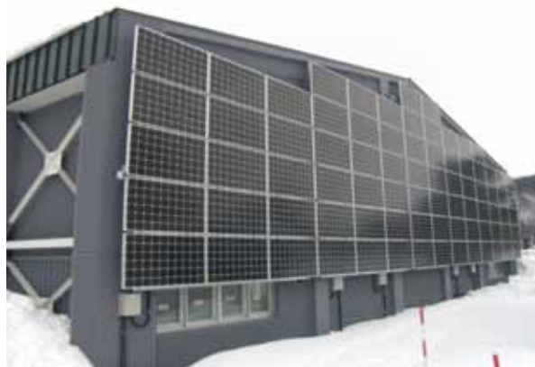
黒松内小学校屋内体育館 太陽光発電設備の設置
