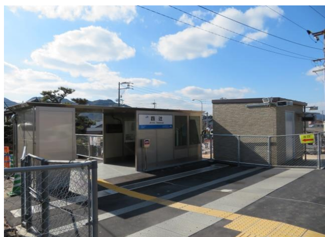
ホーム側から見たところ（右の建物は機械室）
