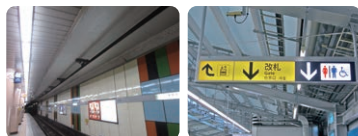
▲LEDを用いた駅照明 ▲LEDを用いたサインシステム
