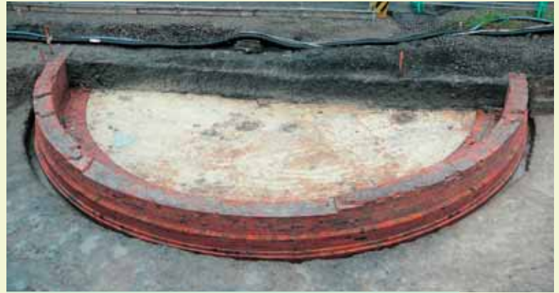
第1図 姫路駅の初代転車台の跡（北半部、北から） 側壁はレンガ積み、床は漆喰で仕上げている。
