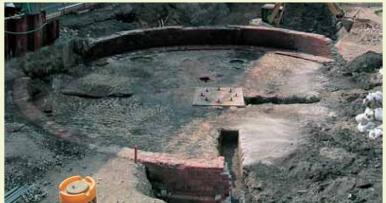
第2図 姫路駅の初代転車台の跡（南半部、東から） 中央支承部と排水枡が確認できる。
