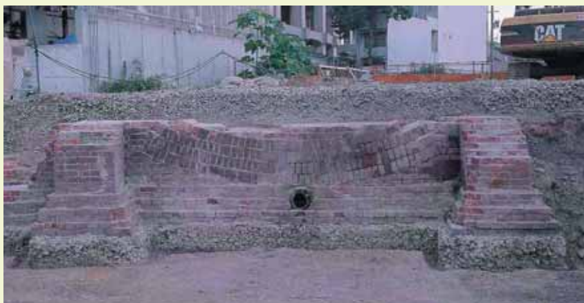
第8図 扇形機関庫レンガ積みの基礎側面写真(東から)
