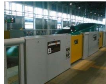
在来線駅へのホームドア設置
