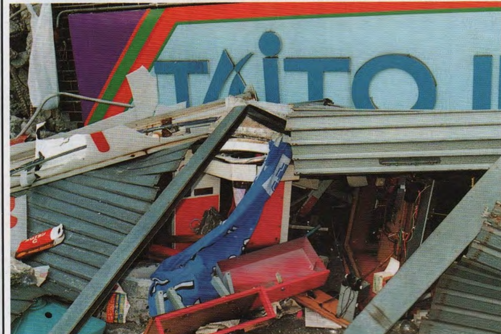
この写真は西宮市のテツカ所有5階建てビルだが、1階にあったはずのタイトーのロケは地下にもぐり込んでしまい、地面のわずかなすき間から店内の倒壊したゲーム機などが見える(下)。2階事務所、3-5階は住宅だった
