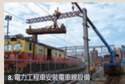
6. 兩部維修車共同作業安裝電力設備
