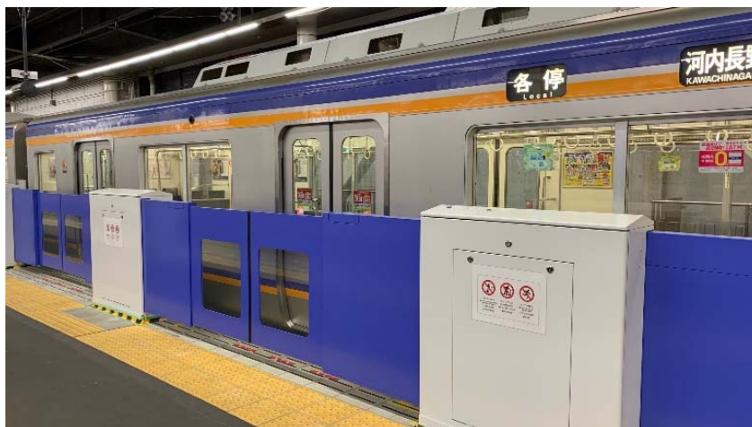
工事中のホームドア（3月8日撮影）
