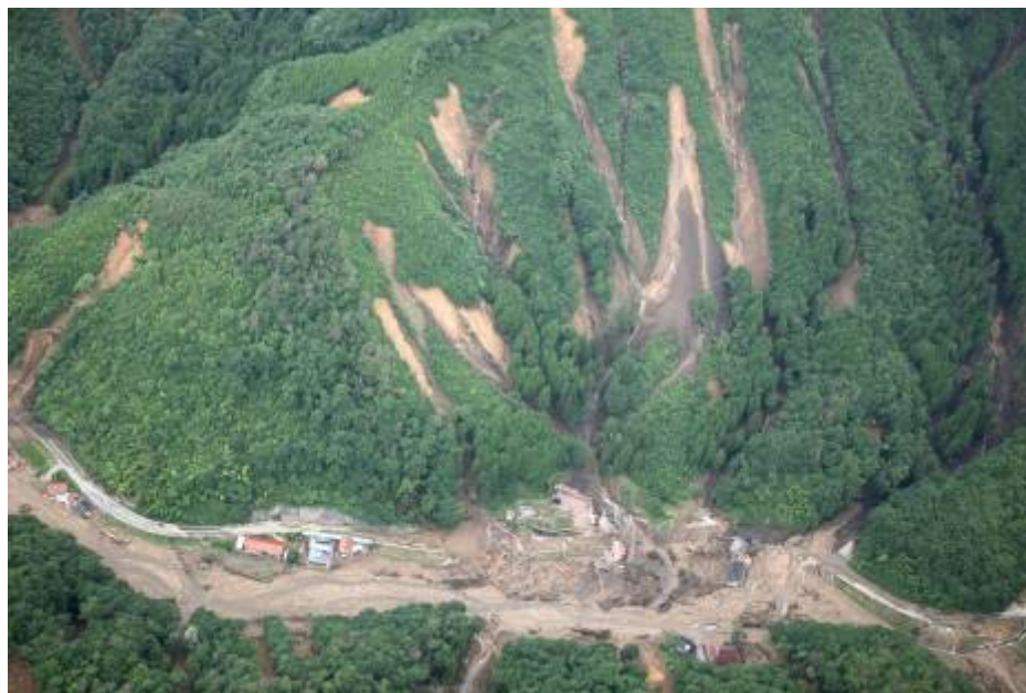
被災状況(篠堂地区)
