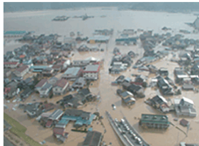
集中豪雨により浸水した状況(兵庫県H16.10)
