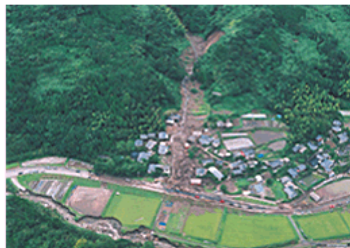
集中豪雨による土砂災害の状況(鹿児島県H17.9)
