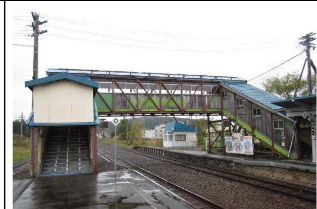
軟弱地盤上の乗換跨線橋
