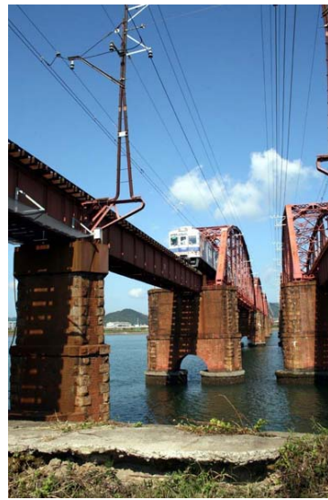
【南海電気鉄道㈱ 紀ノ川橋梁】 (和歌山県和歌山市)
