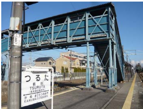
【JR 日光線鶴田駅 跨線橋】 (栃木県宇都宮市)
