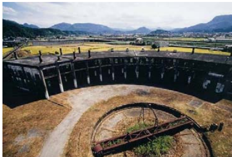
【旧豊後森機関区 扇形機関庫と転車台】 (大分県玖珠郡玖珠町)
