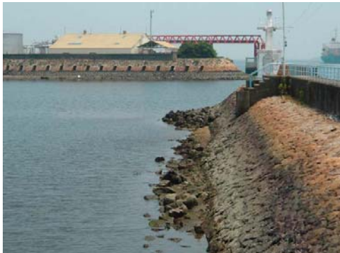
【四日市港 潮吹き防波堤（旧港北防波堤）】 (三重県四日市市)
