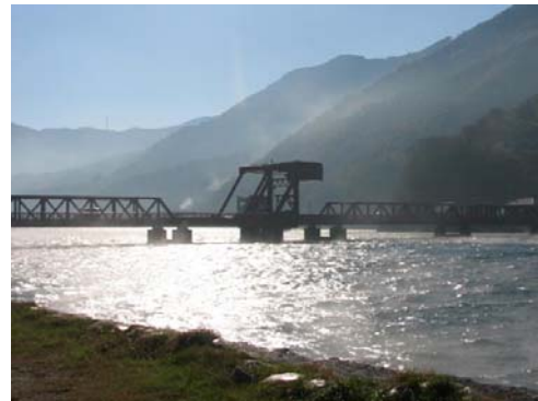
【長浜大橋】 （愛媛県大洲市）
