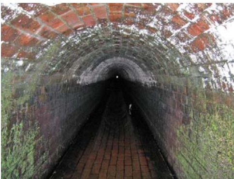
【西光寺野疎水路】 (兵庫県神崎郡市川町、神崎郡福崎町)
