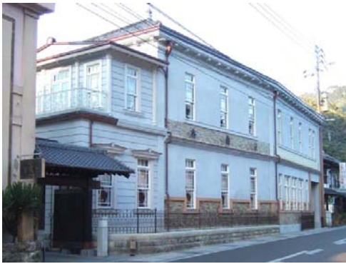
【香蘭社 本社社屋】 (佐賀県西松浦郡有田町)
