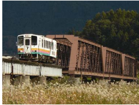
【山形鉄道最上川橋梁（移設）】 （山形県西置賜郡白鷹町）
