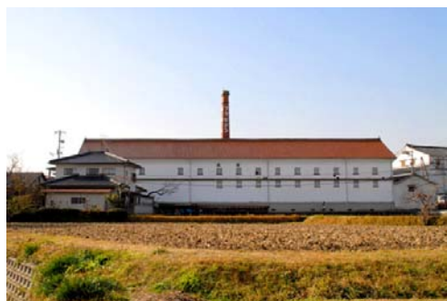
【福美人酒造(株) 醸造蔵及び赤煉瓦積煙突】 (広島県東広島市)
