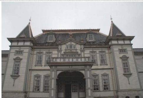
【旧米沢高等工業学校本館】 (山形県米沢市)
