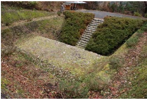
【大崖砂防堰堤】 (長野県木曾郡南木曾町)
