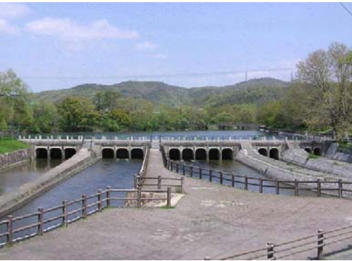
【高梁川東西用水酒津樋門】 (岡山県倉敷市)
