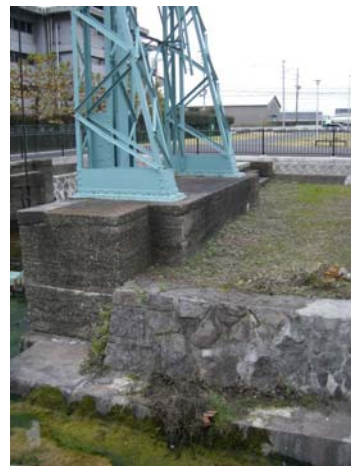
【名古屋港船見ふ頭旧貯木場跡の人造石護岸】 (愛知県名古屋市港区)
