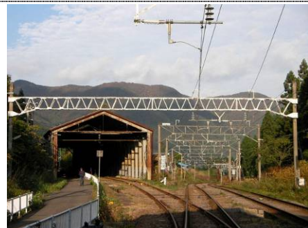
【奥羽本線板谷峠のスイッチバック遺構】 （山形県米沢市）
