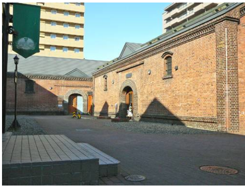
【旧上川倉庫㈱ 倉庫群】 (北海道旭川市)
