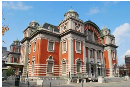
【大阪市中央公会堂】 (大阪府大阪市北区)
