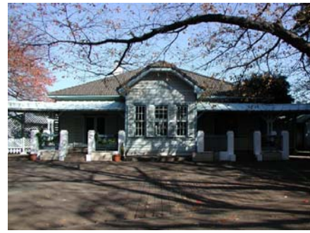
【山手公園 旧山手 68 番館 (外観を復元)】 (神奈川県横浜市中区)
