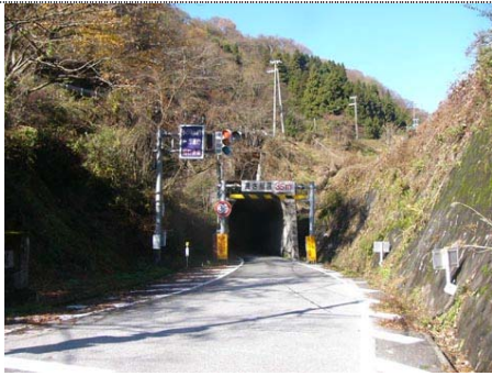
【旧柳ヶ瀬隧道（福井県側）】 （福井県敦賀市、滋賀県伊香郡余呉町）
