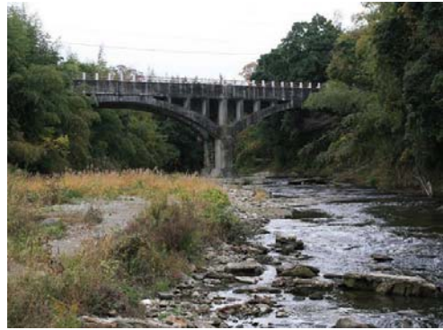
【淡河川疏水 御坂サイフォン】 (兵庫県三木市)
