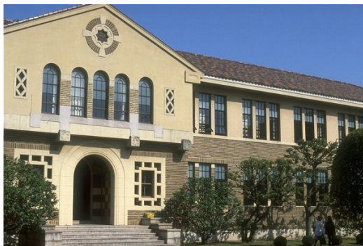
【神戸女学院建築物群 文学館】 （兵庫県西宮市）
