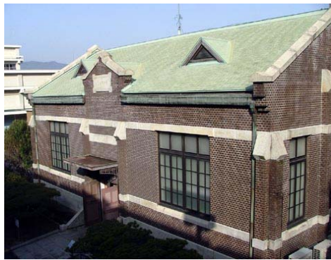
【広島市水道資料館（旧牛田浄水場送水ポンプ室）】 (広島県広島市東区)
