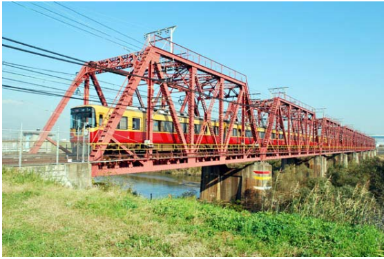
【京阪電気鉄道㈱ 木津川橋梁】 (京都府八幡市)
