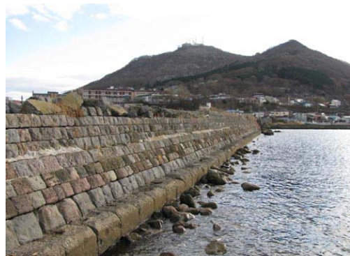
【函館港 船入澗防波堤】 (北海道函館市)
