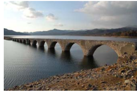
【タウシュベツ川橋梁】（北海道河東郡上士幌町）
