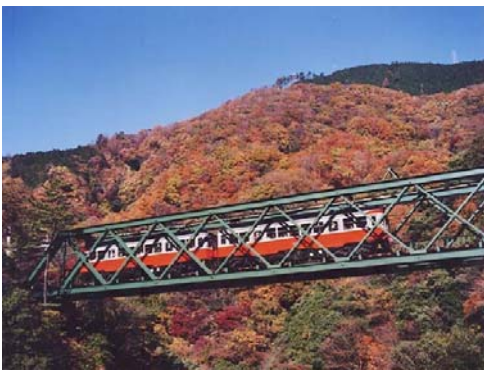
【箱根登山鉄道：早川橋梁（通称「出山の鉄橋」）（移設）】 （神奈川県足柄下郡箱根町）
