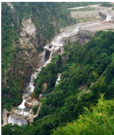
【白岩砂防堰堤】 (富山県富山市、中新川郡立山町)
