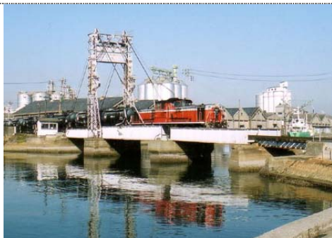
【末広橋梁（旧四日市港駅鉄道橋）】 （三重県四日市市）
