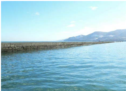
【小樽港 北防波堤】 (北海道小樽市)
