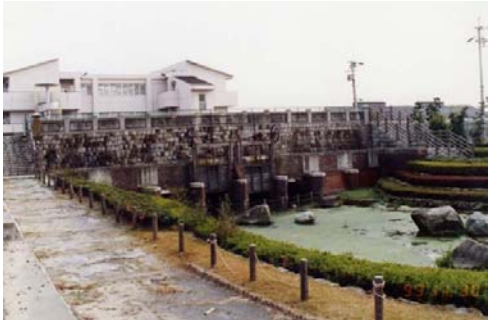
【立田輪中人造堰樋門】 (愛知県弥富市)
