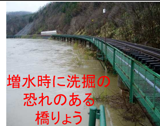
(例: 宗谷線 糠南・雄信内間 問平陸橋)
