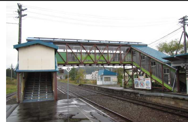
軟弱地盤上の乗換跨線橋
