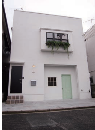
→元は1階がお好み焼き屋だったという戸建てのリノベーション
