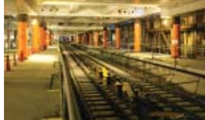
工事中の武蔵小山駅
