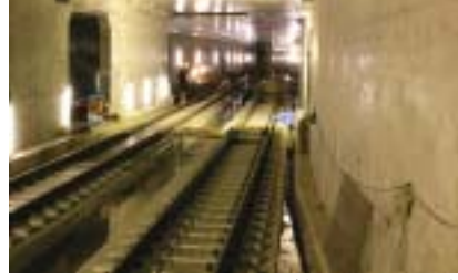
工事が進む武蔵小山駅付近
