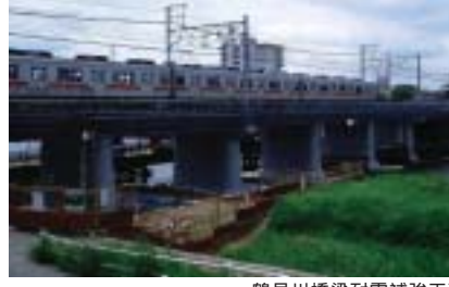
鶴見川橋梁耐震補強工事
