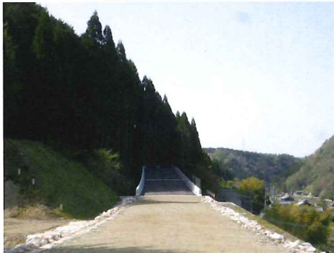
施工の状況（鋼製栈橋）
