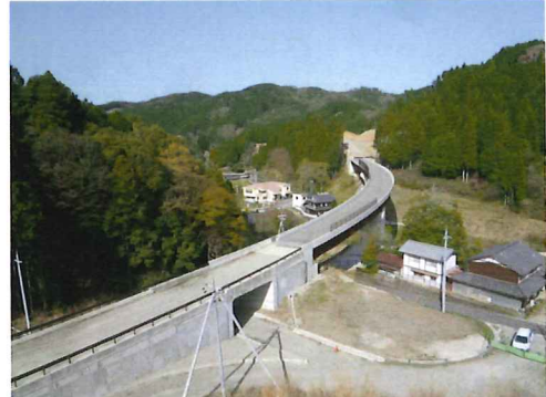
施工の状況（奥山田2号橋）
