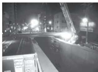
写真—13 アプローチ部 (U型部)
