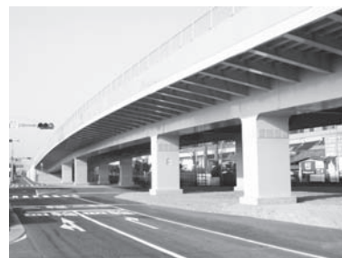
写真-1 完成写真(原田高架橋)
