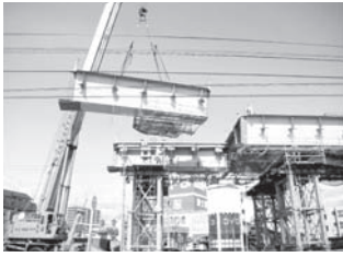
写真一十九 上部工の地組立
