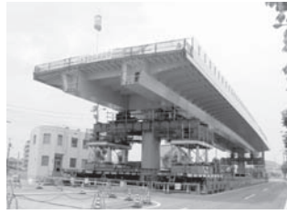
写真二十 地組立完了状況
