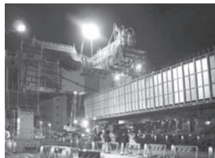
写真—11 一括吊上げ状況
