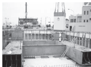
写真-2 下部工・基礎の架設 (鋼製橋脚)
