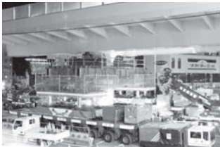
写真二十二 ジャッキダウン
