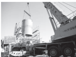
写真-16 鋼管ソケットの設置
