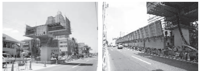
写真—7 橋脚柱部架設状況
