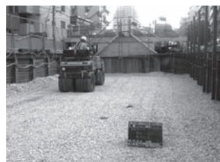
写真—14 アプローチ部 (L型部)
