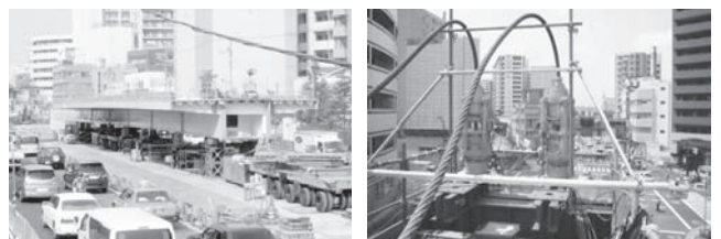
写真—9 A1背面地組桁ヤード
