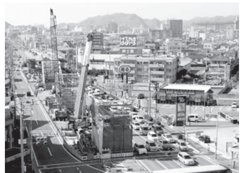
写真-18 上部工と基礎の同時施工
