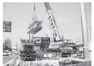
写真-3 上部工の架設 (鋼製橋脚)
