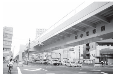
写真—4 完成写真（新小岩陸橋）
