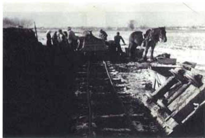
馬ト口による築堤盛土(豊城築堤)(昭和26年)
