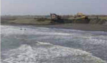
サンドバイパス (浚渫土を利用した養浜工の施工)
