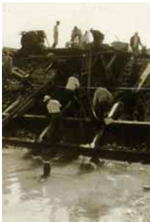
護岸工事(昭和27年)
