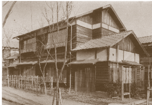
〔37 瀧頭住宅外観〕
