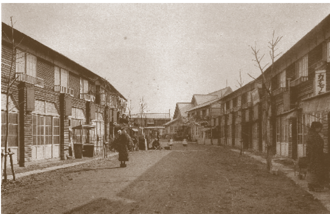
〔21 砂町住宅店舗街〕
