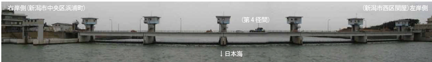
写真-1 新潟大堰管理橋全景(下流側より望む)
