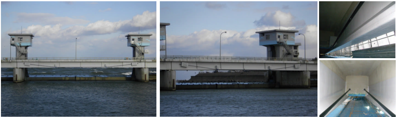
写真-8 施工完了
