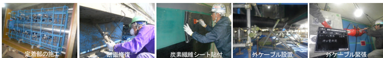
写真-7 施工状況
