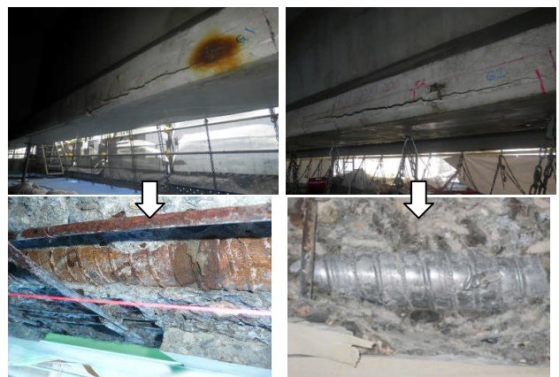
写真-6 G1(左上), G2桁(右上)クラックとはつり後(下)
