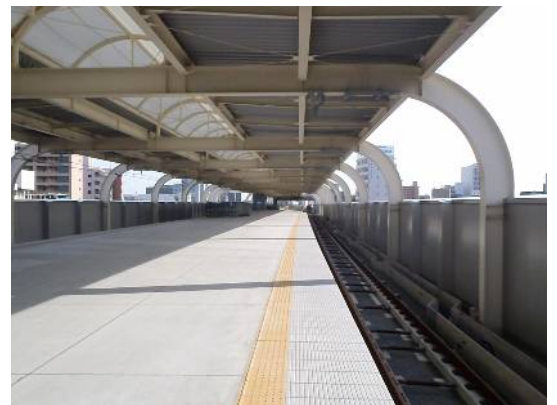
使用を開始する京急蒲田駅3階下りホーム
