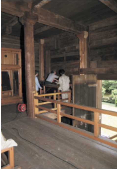
挿図1 中倉2階東側壁の調査風景
