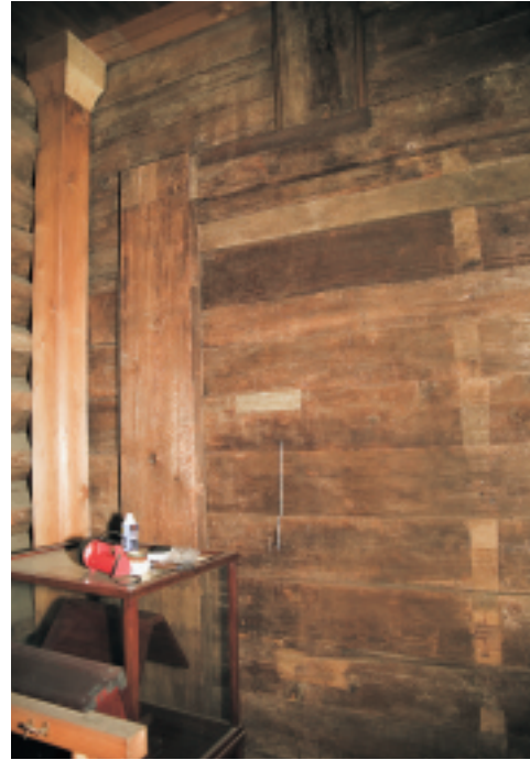
挿図2 中倉2階東側壁の年輪調査箇所
