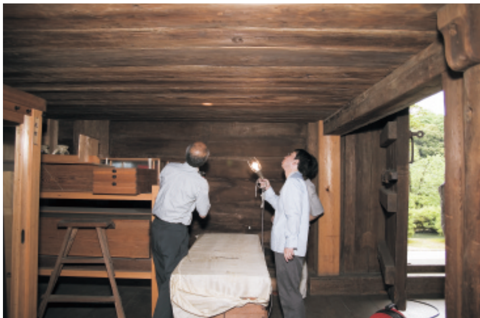
挿図3 中倉1階天井板調査風景
