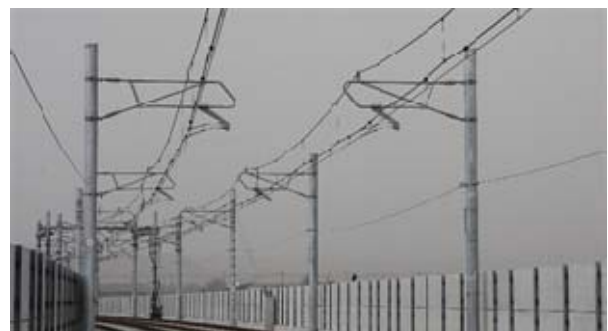
図4 き電ちょう架式コンパウンド架線
