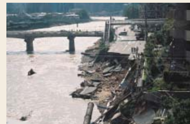
台風23号による被害「流失した旧国道176号(西宮市塩瀬町生瀬)」
