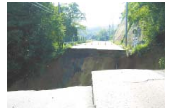
国道173号(綾部市寺町)
