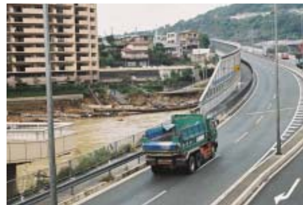
名塩道路(手前)と崩落した旧国道176号
