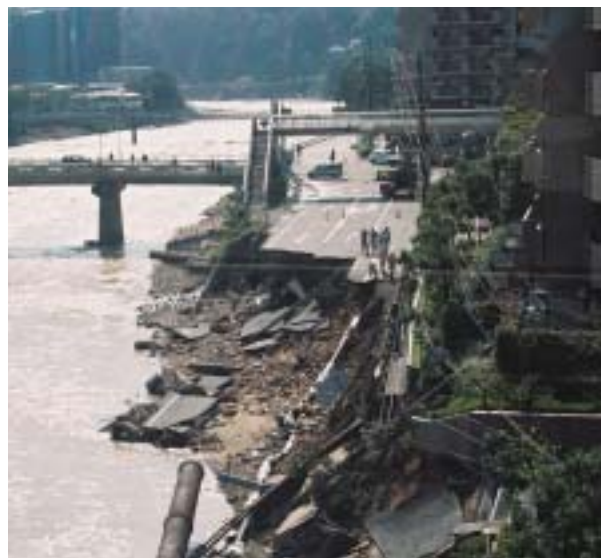
流失した旧国道176号
