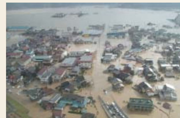
台風23号による被害「豊岡市内(円山川右岸)」
