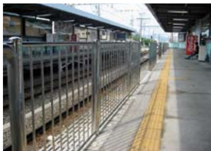
ホーム転落防止柵
