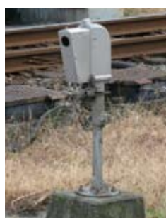
踏切障害物検知センサー
