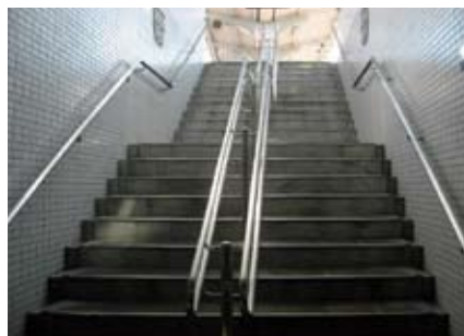
階段中央手すり
