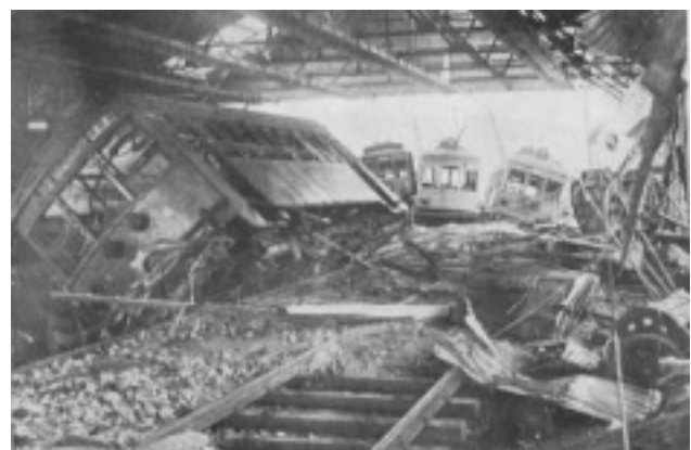
阪堺電鉄車庫内の被害
