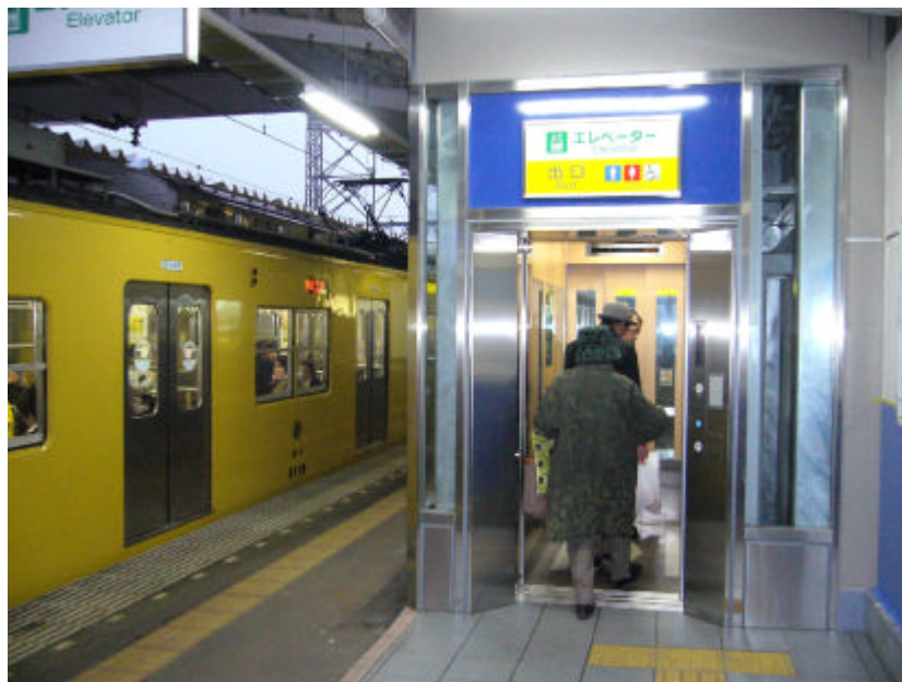
恋ヶ窪駅のホームに完成したエレベーター
