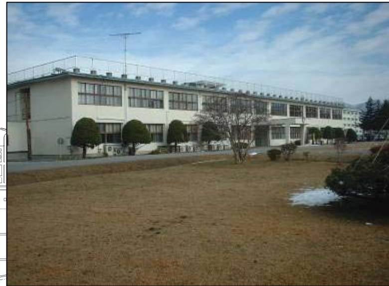
建替建物(庁舎) RC-2 2,003㎡(S36建設)
