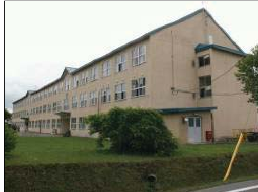
既存建物(庁舎) RC-3 5,810㎡(S29建設)
