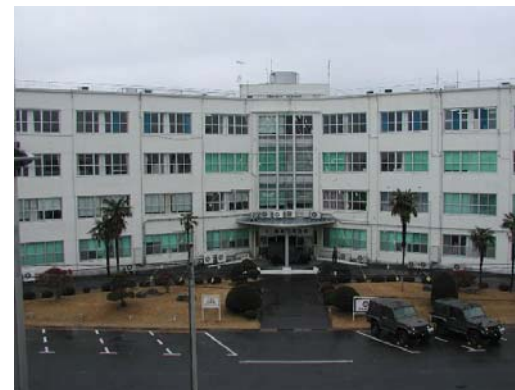
既存建物(庁舎) RC-4 6,367㎡ (S36建設)
