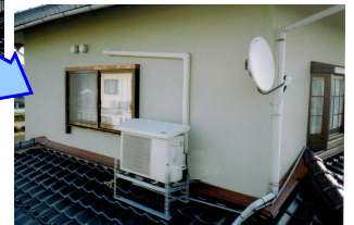
防音工事実施後
