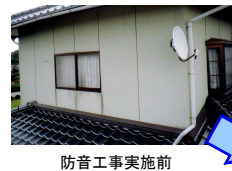
防音工事実施前
