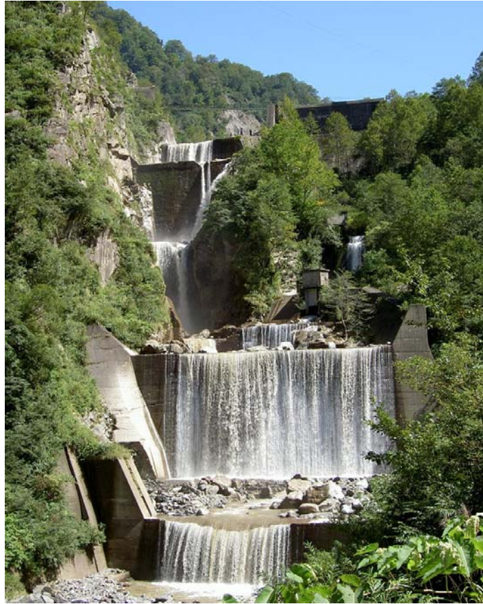
白岩砂防堰堤
