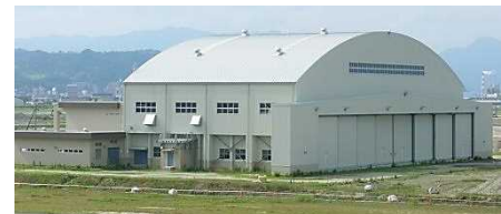
整備用格納庫
