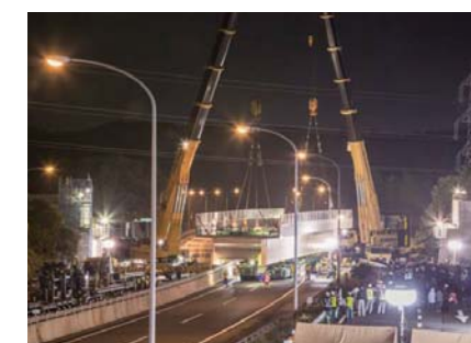
名神・湖東三山スマートIC ランプ橋の夜間架設
