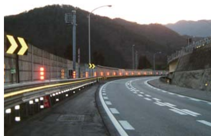
速度抑制レーンマーク・矢羽板
