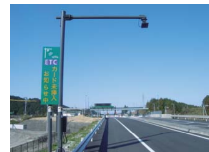
お知らせアンテナ ETCカードの未挿入や有効期限切れを料金所手前で知らせるアンテナの整備を進めます。
