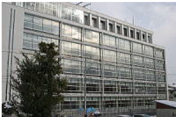
免震構造を採用した他事例：妙高市庁舎
