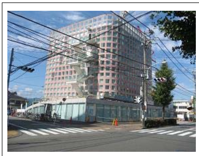
建設中の福生市役所新庁舎
