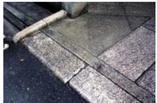
玄関側溝のふた石
