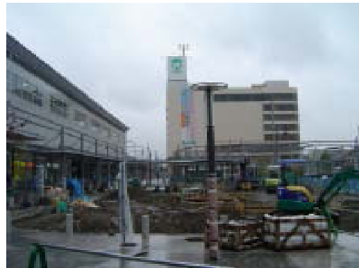
整備が進む駅前広場と大和小松店
