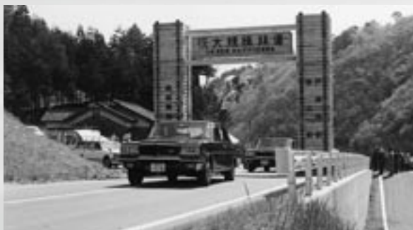
昭和51年度から着工し、14年かけて完成した大規模林道
