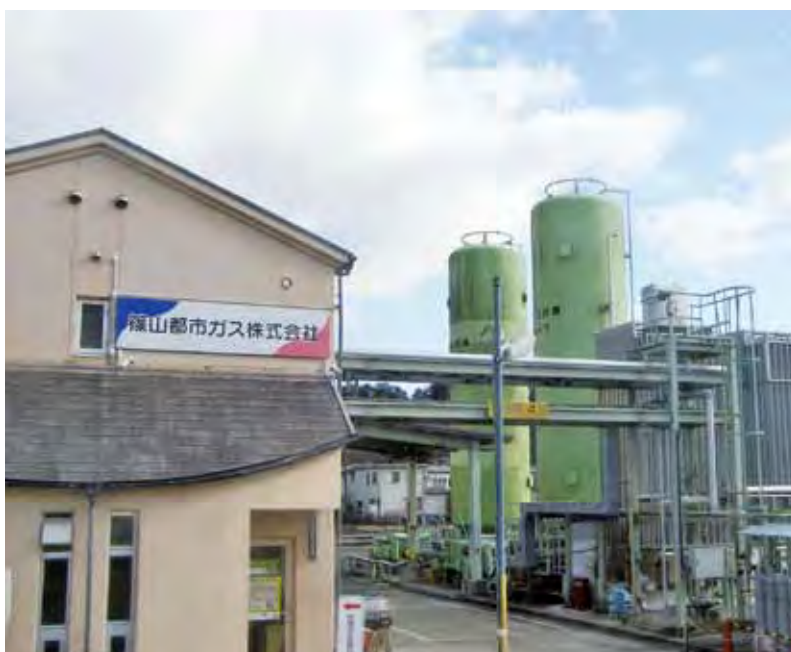
▲篠山都市ガス（株）（ガス製造所併設）
