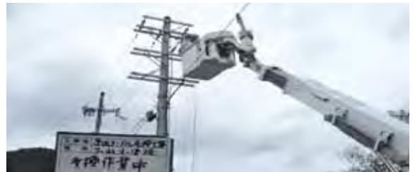
▲受変電設備工事 高所作業
