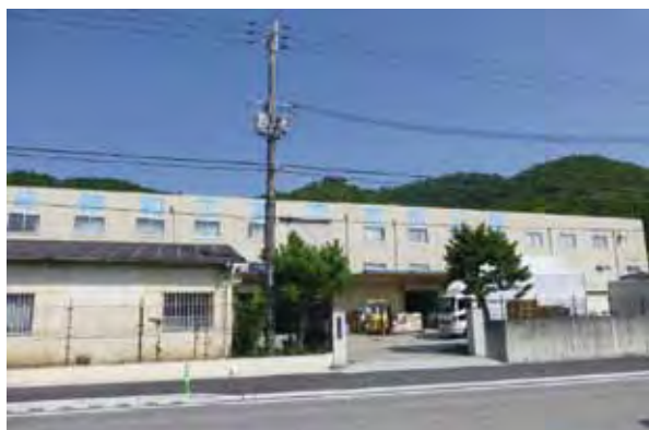
▲古市工場外観
