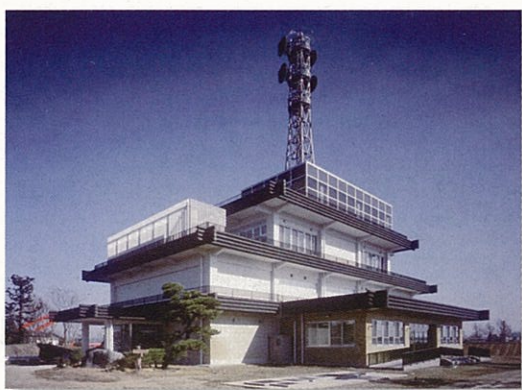
新しくなった大河津資料館の4階には展望室が設けられ、大河津分水周辺の美しい景色を眺めることができます。
