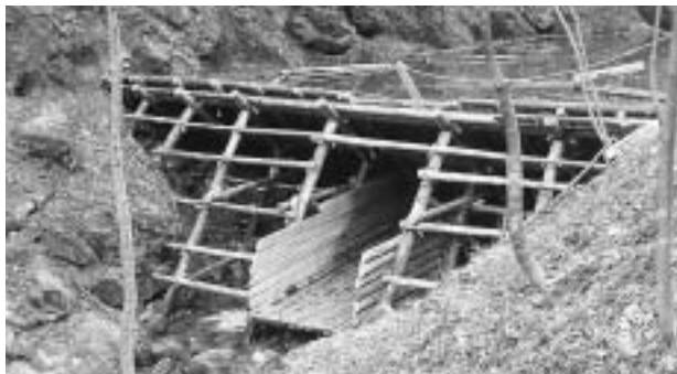
鉄砲堰全景（下流側）
