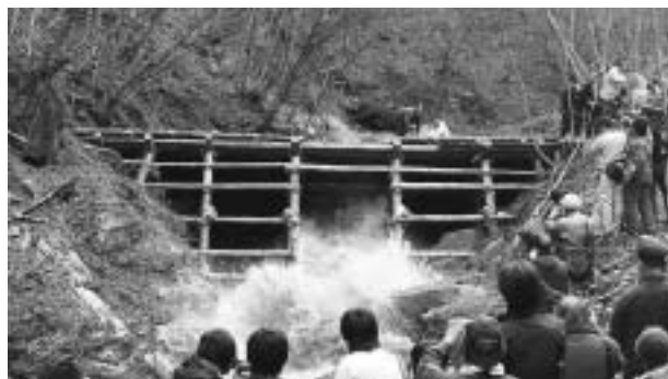
はらい棒を倒して放水の瞬間
