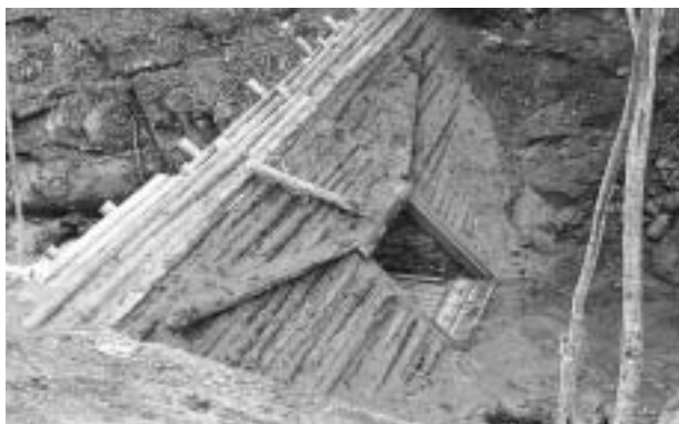
放水後の鉄砲堰内側（防水詰め土、放水口の鉄砲板）
