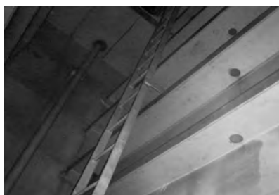
図 5.7 S.I 機能を有したユニバーサルプライマー (3年後の状態)
