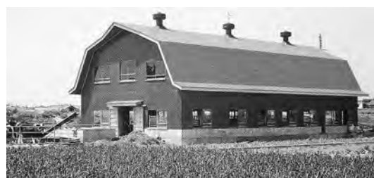
図 5.25 着色亜鉛鉄板屋根
