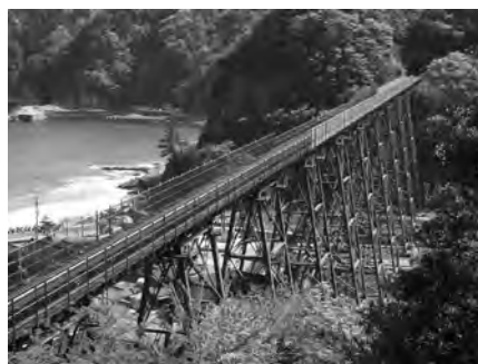
図 3.7 余部鉄橋 (日本ペイント提供)
