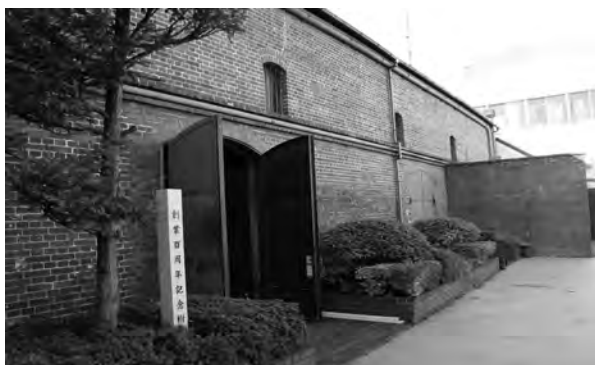
図3.12 明治時代の煉瓦建て油ワニス工場(日本ペイント東京事業所内)
