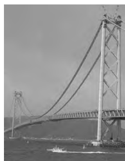
図 4.21 フッ素樹脂塗装の明石大橋
