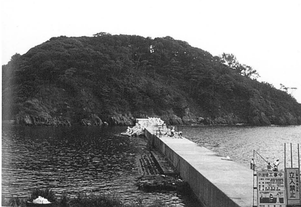
写真1 弁天島の北面と完成した防波堤
