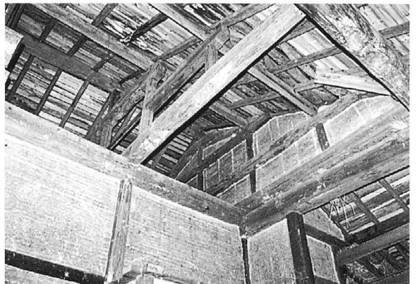
屋根裏・梁の状況
