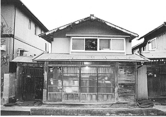
建物正面全景
