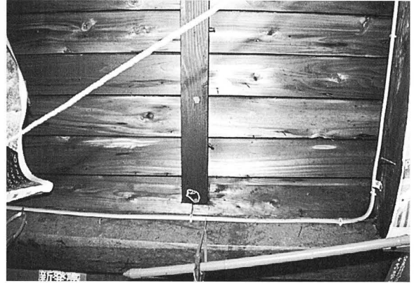
二階天井部分
