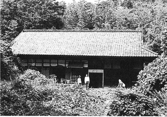
建物正面全景
