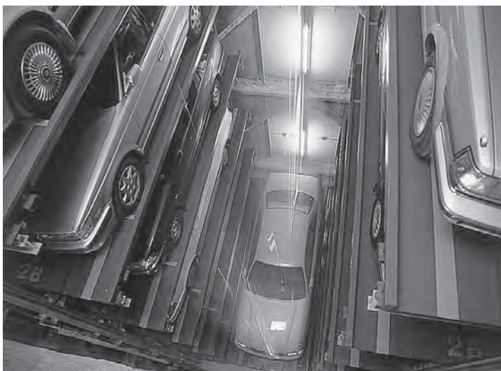
長年のエレベータ技術を応用した立体駐車設備「シティパークEV」(1990年2月)
