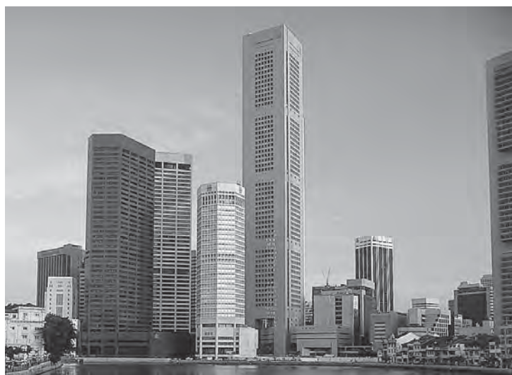
世界的建築家・丹下健三氏の設計によるシンガポールの「OUBセンター」（1986年4月）
