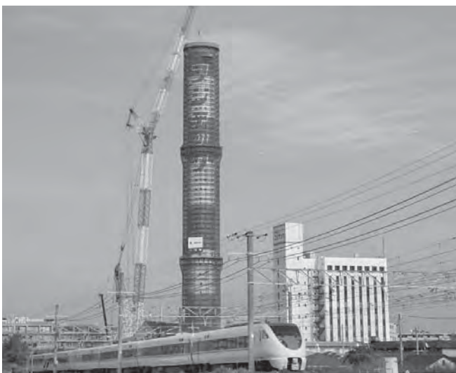
巨大クレーンにて解体工事中の旧本社「エレベータ研究塔」（2008年11月）
