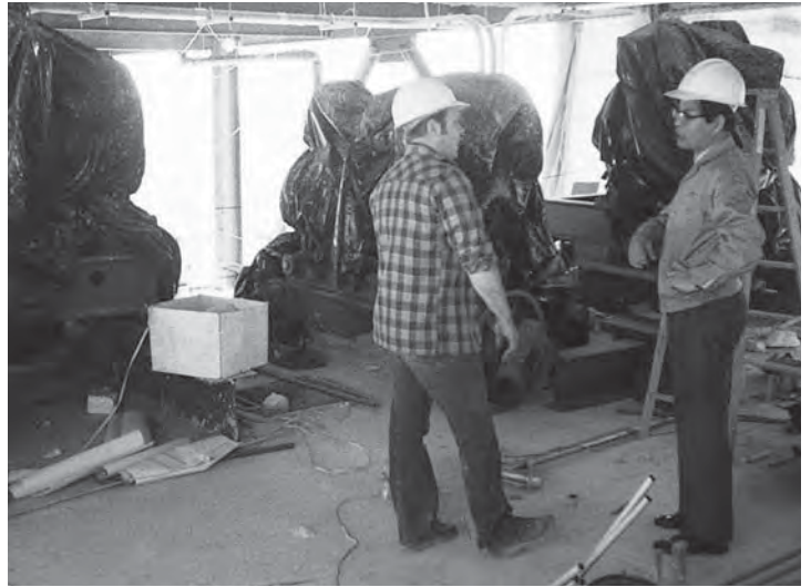
「ラマータワービル」の据付現場にて打ち合わせをする唐野工務部長（1979年10月）
