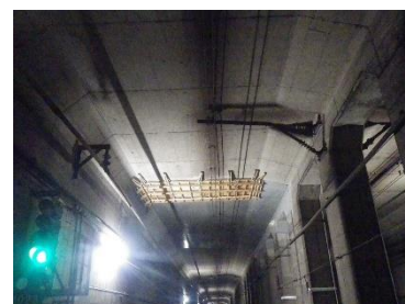
万騎が原トンネルの内部の様子
