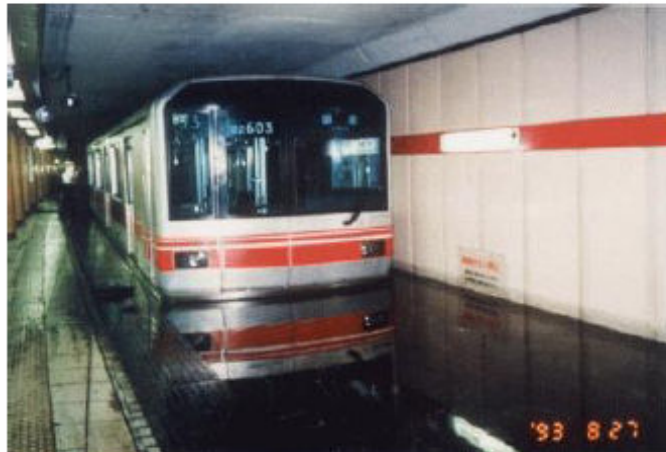
写真8-1 平成5年台風11号による丸の内線浸水状況 写真提供：東京地下鉄株式会社
