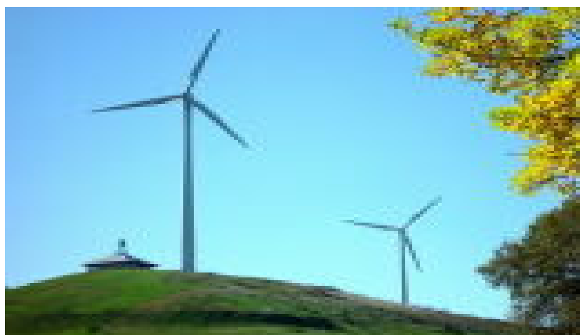
(ドイツの屋上緑化～風力発電と屋上緑化を組み合わせている例)
