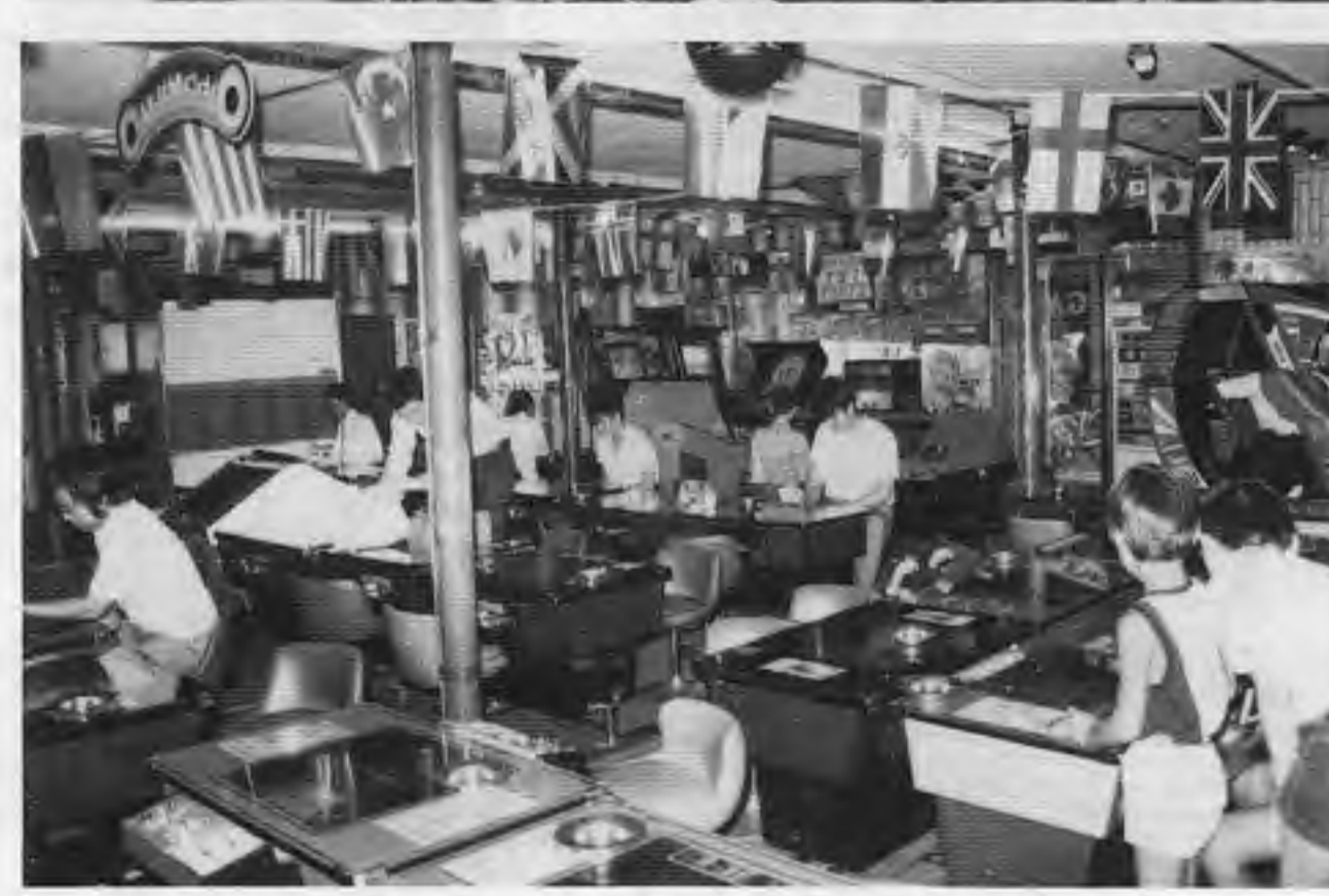
「ゲームプラザ・カマタ」(スーパーセブン)の1階と2階(上)フロアにて。2階は窓が多いため、かなり明るい
