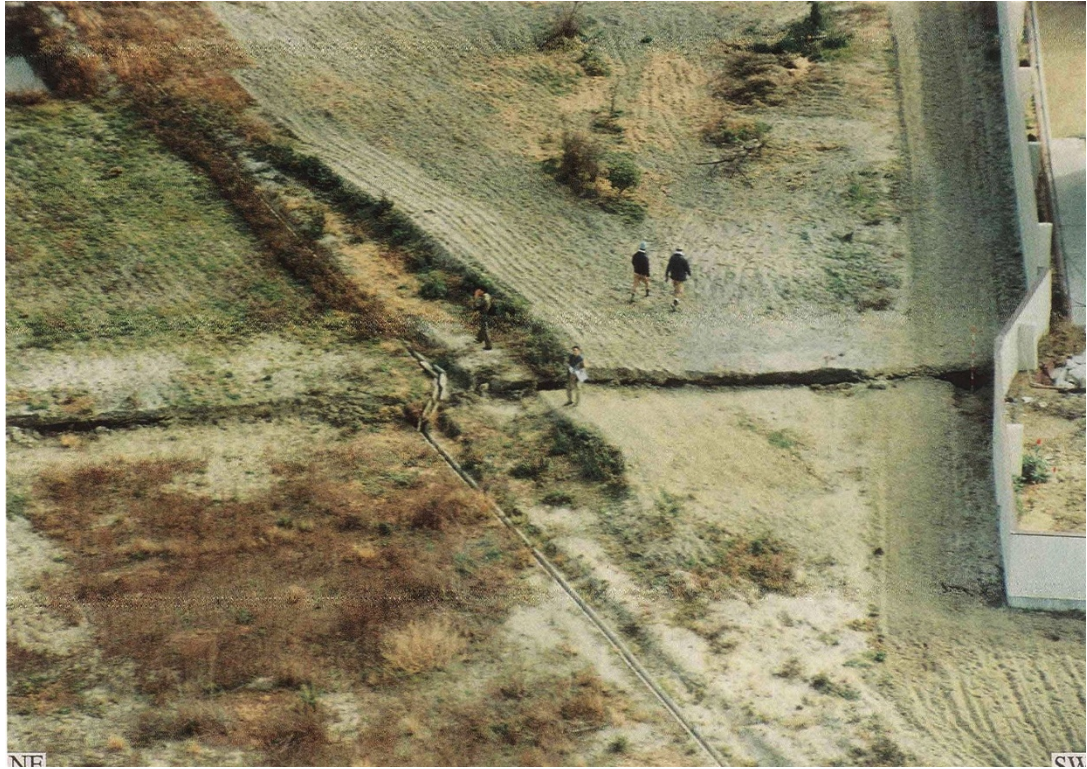
図5 野島断層保存館の位置で兵庫県南部地震により食い違いを見せた野島断層 (1995年1月、中田 高 撮影)。
