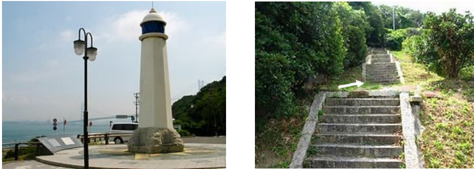
図9 (左) 江崎灯台、(右) 灯台へ登る途中の石積み階段に残る地震時の水平横ずれ変位。
