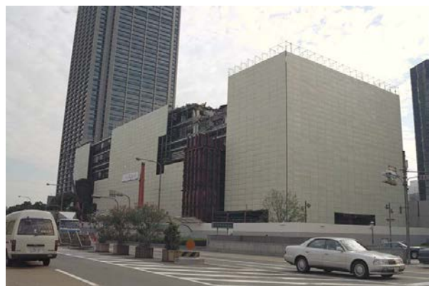
④1995 年 9 月 25 日 補修工事が始まった 2 号館
