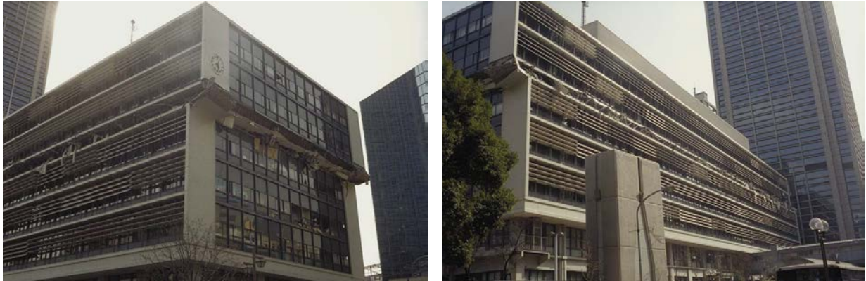
図 14 ①、② 1995 年 1 月 18 日 震災直後の神戸市役所 2 号館
