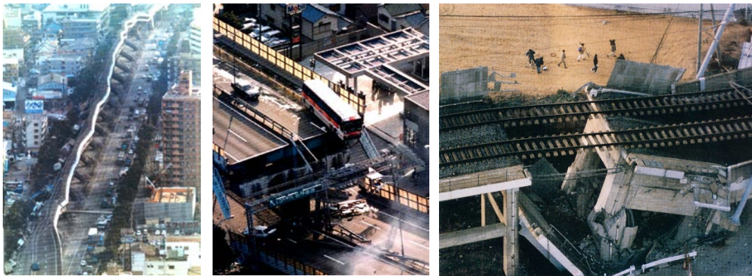
図 13 ①～③ 兵庫県南部地震に伴う高速道路や鉄道高架の被害。
