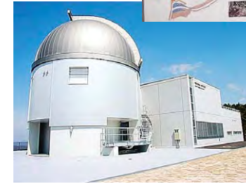
南西方向から望んだ天文台施設全容
