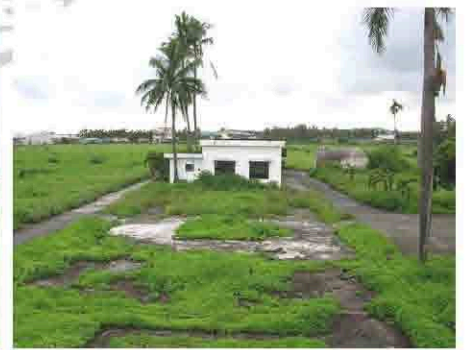
【圖 3-3-137】菸類試驗所屏東改良場葉煙草乾燥室拆除廢棄現況。(本研究拍攝 2007.12)
