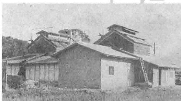
【圖3-3-123】嘉義地區葉煙草乾燥室舊景；前排增建土塊造倉庫，後棟廊下空間改築竹筒造葉煙草調理空間。（《臺灣／特用植物》，1939）
