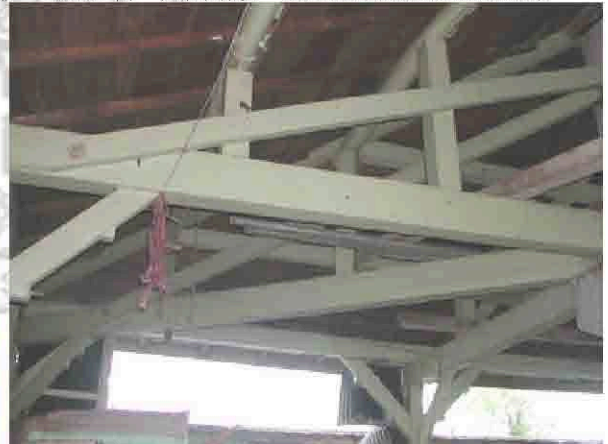
【圖 3-3-118】菸類試驗所花蓮改良場葉煙草乾燥室廊下屋架現況，戰後菸酒公賣局工務課使用原圖改建。（本研究拍攝 2007.5）
