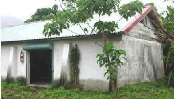
【圖 3-3-112】菸類試驗所花蓮改良場堆肥小屋現況，右側山牆保留原雨淋板構造。(本研究拍攝 2007.5)
