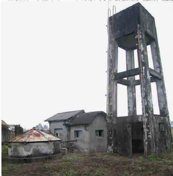
【圖 3-3-127】菸類試驗所灌溉設施暨飲用水設施遺構現況，幫浦室鄰接設施疑似戰後增建，水塔位置與構造已更改，水井保存完善。（本研究拍攝 2007.3）
