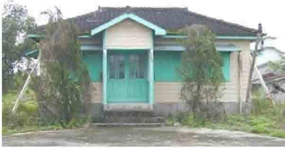
【圖 3-3-109】菸類試驗所花蓮改良場事務室，入口增建玄關四角隅扶壁木柱，與原始圖有出入。(本研究拍攝 2007.5) 【圖 3-3-110】菸類試驗所花蓮改良場事務室，室內保留日治時期真壁構造與門扇。(本研究拍攝 2007.5)
