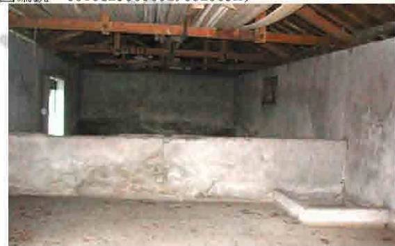
【圖 3-3-113】菸類試驗所花蓮改良場堆肥小屋，室內 3 尺隔牆區劃堆積場，連接戶外收集槽。(本研究拍攝 2007.5)
