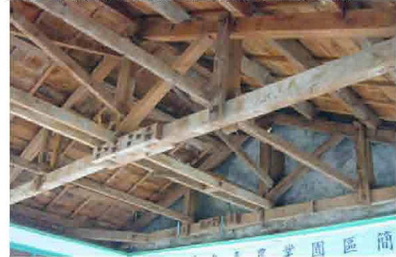
【圖 3-3-115】菸類試驗所花蓮改良場，原調理室及葉煙草貯藏所，屋架保有真束小屋構法。(本研究拍攝 2007.5)
