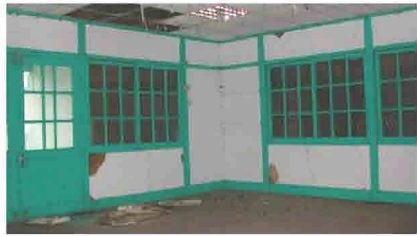
【圖 3-3-109】菸類試驗所花蓮改良場事務室，入口增建玄關四角隅扶壁木柱，與原始圖有出入。(本研究拍攝 2007.5) 【圖 3-3-110】菸類試驗所花蓮改良場事務室，室內保留日治時期真壁構造與門扇。(本研究拍攝 2007.5)
