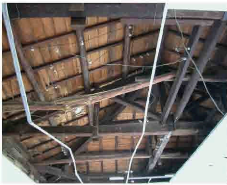
【圖 3-3-140】菸類試驗所屏東改良場事務所採寄棟造洋小屋真束小屋組木構現況。【圖 3-3-141】菸類試驗所屏東改良場事務所標本室（圖右）療養室（圖左）背向，以廊下連接。（本研究拍攝 2007.12）【圖 3-3-142】菸類試驗所屏東改良場事務所與療養室廊下現況；圖右大小便所，前端標本室，圖左事務所。（本研究拍攝 2007.12）
