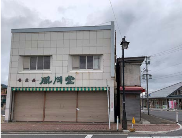
改修前のファサード（2020.6）
