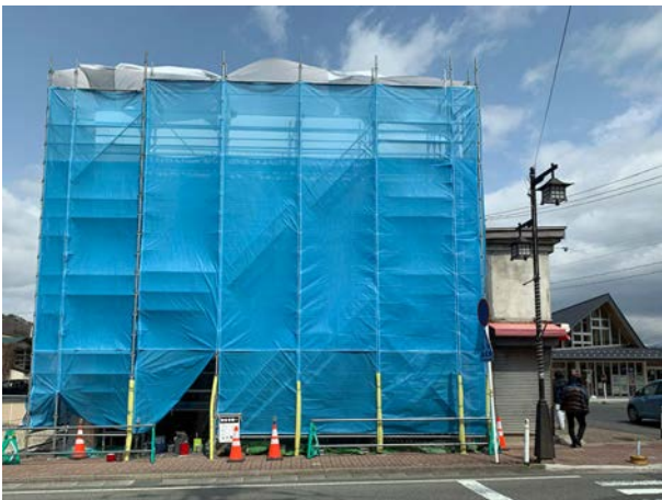
ファサード改修工事中（2021.3）
