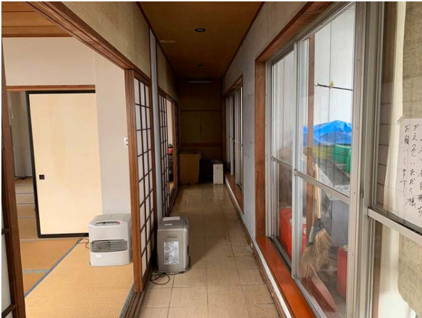
改修前の2階廊下 (2021.3)
