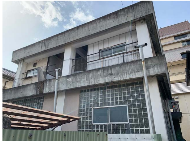
外観、裏路地から見る (2021.3)
