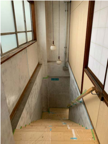
階段床を張り替え (2022.5)
