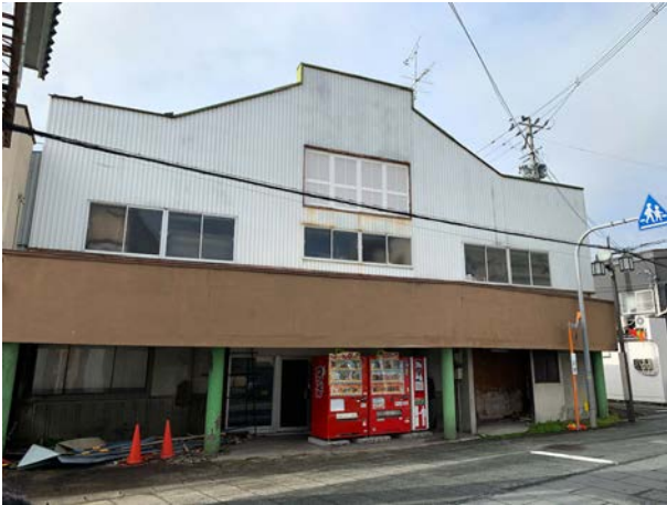
解体前のトキワ館正面 (2019.10)
