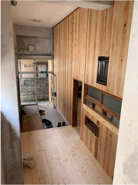
改修後の玄関ホール (2022.5)
