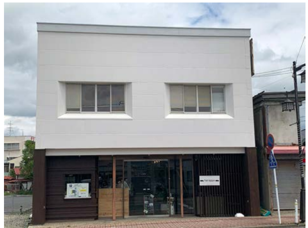
ファサード改修後（2021.5）
